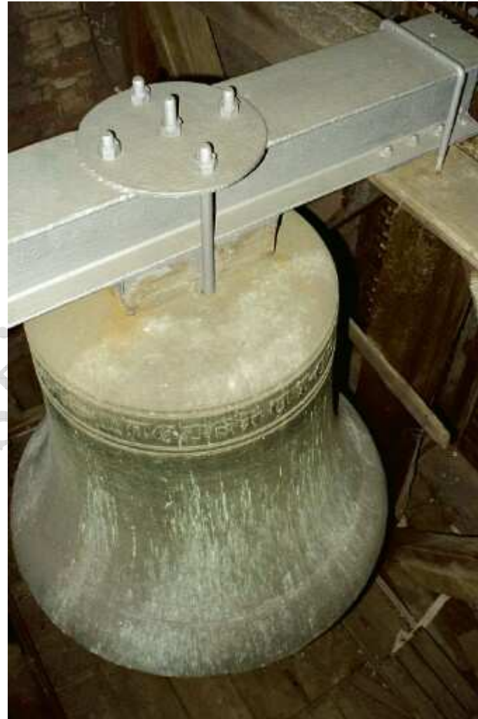
Magnusglocke mit abgeschlagener Krone. (Foto Sebastian Wamsiedler)
