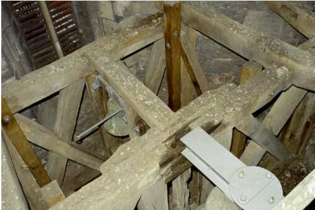
Glockenstuhl Südturm. Vorne Stundenglocke. Hinten Schosselglocke. (Foto Sebastian Wamsiedler)
